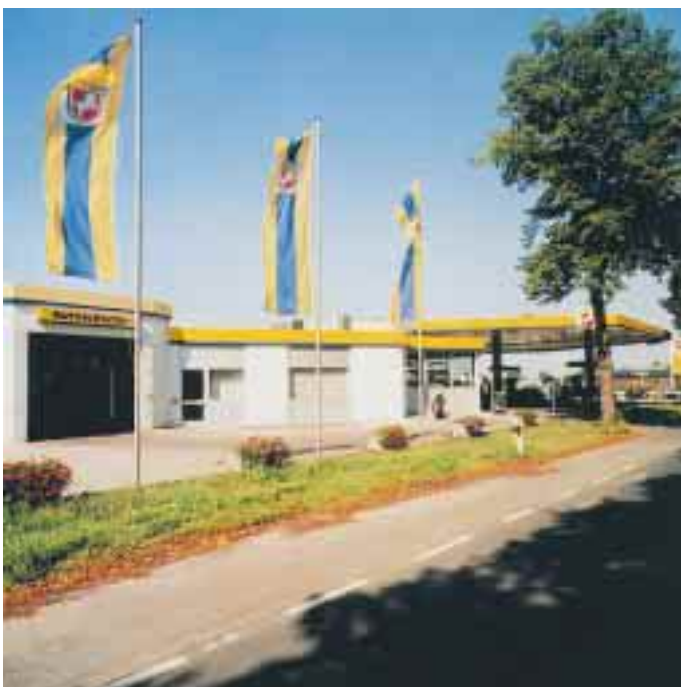
Die Westfalen-Tankstelle in Münster-Roxel wurde in sechs Monaten Bauzeit komplett umgestaltet.
