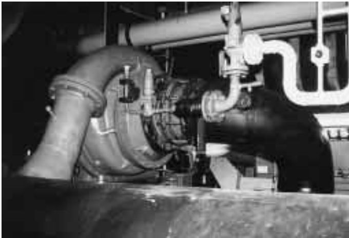
Umrüstung einer R 12-Turboverdichteranlage auf R 134a nach dem Driveline-Konzept im 5. Obergeschoß eines Laborkomplexes. Das linke Bild zeigt den Zustand der R 12-Turboverdichteranlage vor der Umrüstung. Auf der rechten Abbildung ist sichtbar, wie R 12-Turboverdichter und Elektromotor demontiert werden.
