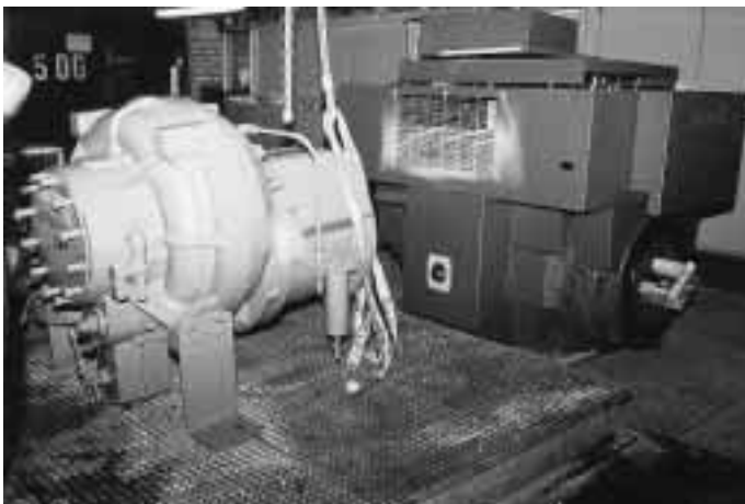
Die linke Abbildung zeigt, wie der R 134a-Turboverdichter und der Elektromotor leicht eingebracht werden konnten. Auf der rechten Abbildung ist zu erkennen, wie die Montage des neuen R 134a-Turboverdichters und des Elektromotors im Maschinenraum erfolgt.
