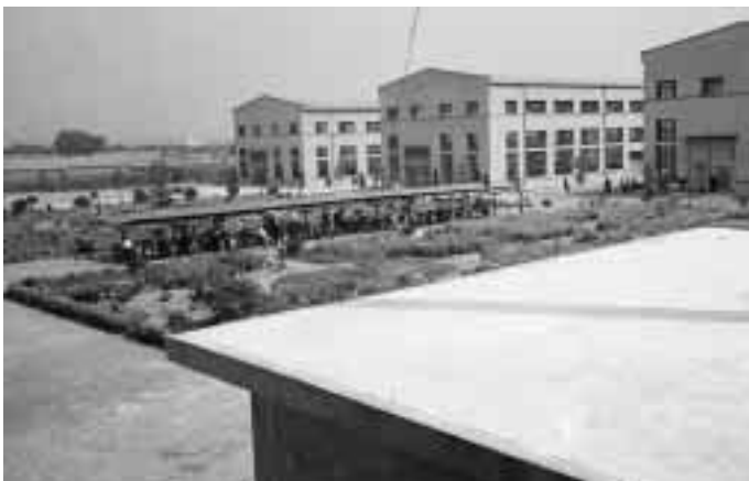
ZIBO HEAD Co. in Wangcun (Provinz Shandong, VR China). In der mittleren Halle werden die Absorber gefertigt.
