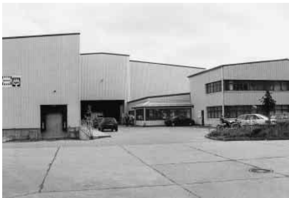
Logistikzentrale mit Tiefkühlagern ( 2088\text{ m}^3 und 3528\text{ m}^3 ) von Langnese-Iglo in Berlin Wartenberg, im Nordostteil Berlins gelegen.
