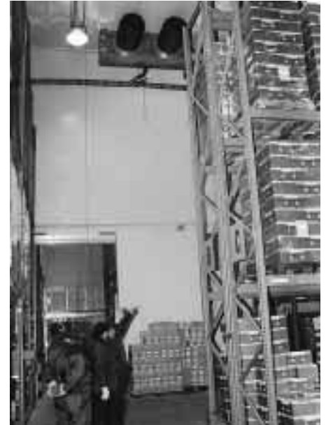
Blick in die beiden Hochregallager von Langnese-Iglo in Berlin Wartenberg. 9 Meter Höhe stehen dort zu Verfügung, die Stellfläche beträgt 232\text{ m}^2 und 392\text{ m}^2 . Das bedeutet 198 Paletten-Grundstellplätze für die Kommissionierung und 630 Vorratsstellplätze. Das durchschnittliche Palettengewicht beträgt 600\text{ kg} . Lagertemperatur -26^{\circ}/-28\text{ }^{\circ}\text{C} – und nicht weniger.
