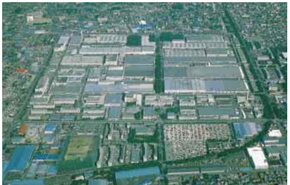
SANYO Tokio Plant in Ora-Gun, Gunma. Die 18 wichtigsten Geschäftsfelder von SANYO einschließlich Entwicklung und Fertigung sind hier auf einem gewaltigen Areal von 1,51 Millionen m 2 zusammengefaßt. Mehr als 50 % des weltweiten Absatzes von SANYO stützen sich auf diesen Produktionsstandort. Die Air Conditioning Division ist auf einer Fläche von 55 075 m 2 – das ist ja auch nicht wenig – mit dabei.
