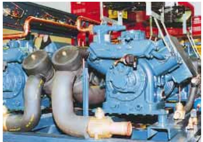
Detailansicht auf die großzügigen Saugleitungsfilter mit Absperrventilen. Am Verdichtergehäuse fällt der externe Druckgassammler auf, der die Zylinderköpfe extern verbindet und so die Wärme aus diesen wegführt und damit die Motortemperatur senkt.
