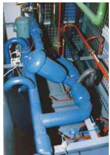
Das Maschinengitter dient nicht zum Schutz des Treibhausklimas, denn Kältemittelkreisläufe sind grundsätzlich dicht. Der Kälteanlagenbauermeister hat im Forschungszentrum Jülich eine „saubere“ Kälteanlage installiert. Hier einige Eindrücke von der R 134a-Verbundanlage mit 3 leistungsgeregelten Danfoss-Maneurop Hermetik-Verdichtern.
