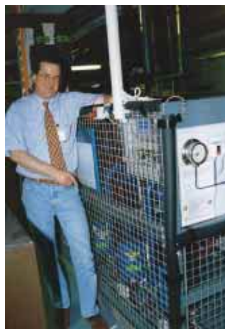
Das Maschinengitter dient nicht zum Schutz des Treibhausklimas, denn Kältemittelkreisläufe sind grundsätzlich dicht. Der Kälteanlagenbauermeister hat im Forschungszentrum Jülich eine „saubere“ Kälteanlage installiert. Hier einige Eindrücke von der R 134a-Verbundanlage mit 3 leistungsgeregelten Danfoss-Maneurop Hermetik-Verdichtern.
