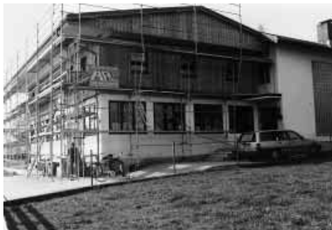
Teilansicht von „Werk 2“ (Gehäuse- und Ventilplattenbearbeitung) der Goeldner-Verdichter-Produktionsstätte HKT Halfing im Chiemgau. Der Gerüstbau täuscht Renovierung vor. Tatsächlich wird hier erweitert und auch die Verdichter-Weiterentwicklung findet künftig in diesem Gebäude Platz.
