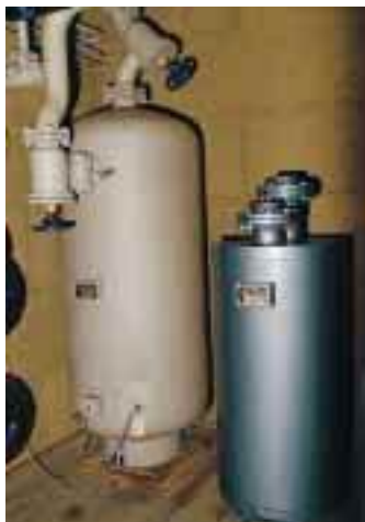
Neuer kompakter Ölabscheider von GRASSO. Links die bisherige, rechts die neue Version.
