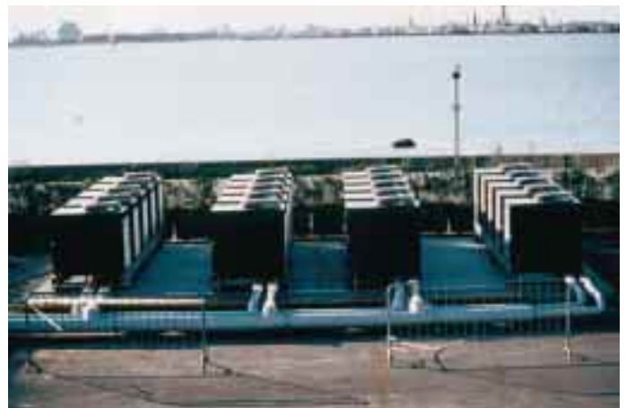
2 × 20 Gasabsorber liefern das Kaltwasser, um die Raumluft im Zeltbau auch im Sommer auf unter 27 ± 1 °C und maximal 50 ± 10 % Luftfeuchtigkeit zu halten.
