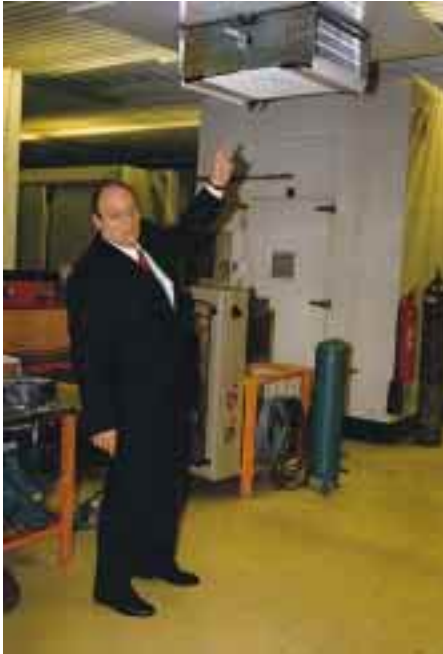
TA ist ein neuer Deckenverdampfer zur Klimatisierung von Arbeitsräumen. Zur Reduzierung der Bauhöhe kommen hierin sogenannte Haubenlüfter zum Einsatz.
