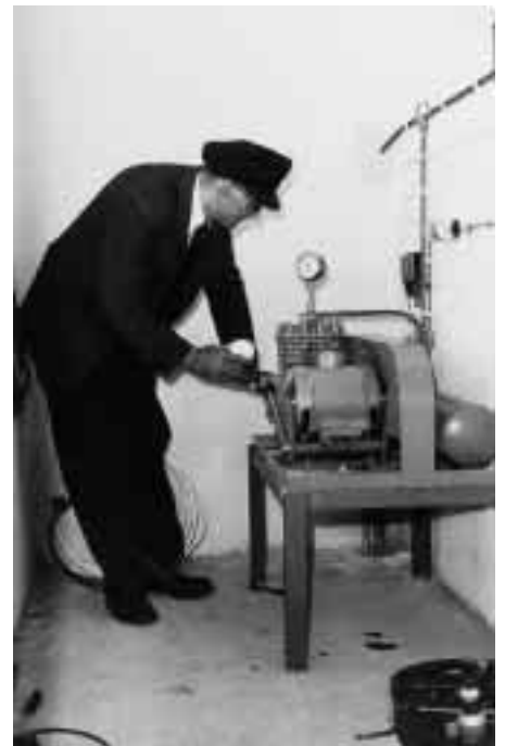
Etwa 1952: Eine moderne Kälteanlage entsteht. Hans-Hermann Schrot bei der Montage. Rohrleitungen werden verlegt (linkes Bild oben), „Apparate“ werden angeschlossen (Mitte oben) und die Schalttafel verklemmt (rechtes Bild oben). Schließlich wurde die offene wassergekühlte Kältemaschine beim Metzger installiert (linkes Bild unten). Vor der Übergabe prüft der Meister die Temperatur (mittleres Bild unten) und die Arbeitsdrücke (rechtes Bild unten). Herbert Emke (Elektro Weber, Emden) galt in den 50er Jahren als anerkannte Koryphäe im Emdener Raum und war für Hans-Hermann Schrot ein guter Lehrmeister.
