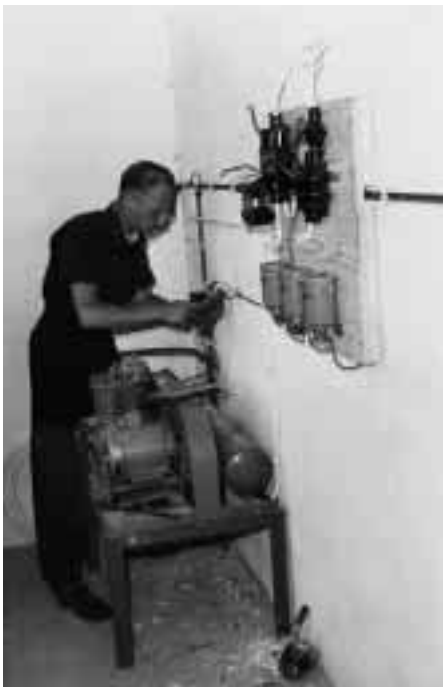
Etwa 1952: Eine moderne Kälteanlage entsteht. Hans-Hermann Schrot bei der Montage. Rohrleitungen werden verlegt (linkes Bild oben), „Apparate“ werden angeschlossen (Mitte oben) und die Schalttafel verklemmt (rechtes Bild oben). Schließlich wurde die offene wassergekühlte Kältemaschine beim Metzger installiert (linkes Bild unten). Vor der Übergabe prüft der Meister die Temperatur (mittleres Bild unten) und die Arbeitsdrücke (rechtes Bild unten). Herbert Emke (Elektro Weber, Emden) galt in den 50er Jahren als anerkannte Koryphäe im Emdener Raum und war für Hans-Hermann Schrot ein guter Lehrmeister.
