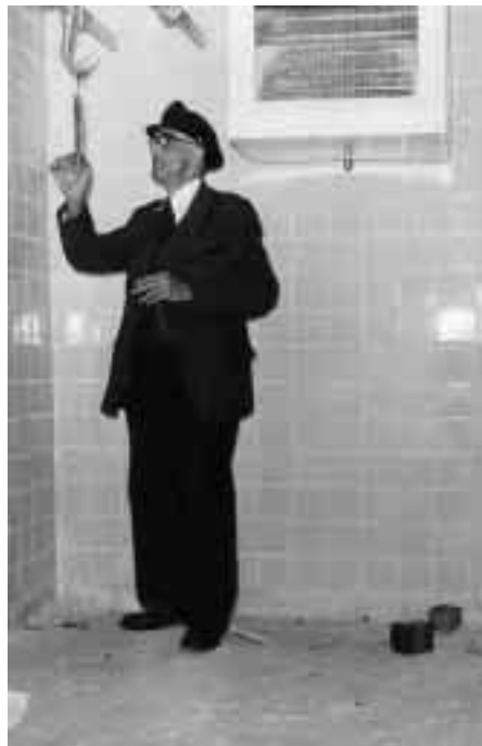
Etwa 1952: Eine moderne Kälteanlage entsteht. Hans-Hermann Schrot bei der Montage. Rohrleitungen werden verlegt (linkes Bild oben), „Apparate“ werden angeschlossen (Mitte oben) und die Schalttafel verklemmt (rechtes Bild oben). Schließlich wurde die offene wassergekühlte Kältemaschine beim Metzger installiert (linkes Bild unten). Vor der Übergabe prüft der Meister die Temperatur (mittleres Bild unten) und die Arbeitsdrücke (rechtes Bild unten). Herbert Emke (Elektro Weber, Emden) galt in den 50er Jahren als anerkannte Koryphäe im Emdener Raum und war für Hans-Hermann Schrot ein guter Lehrmeister.
