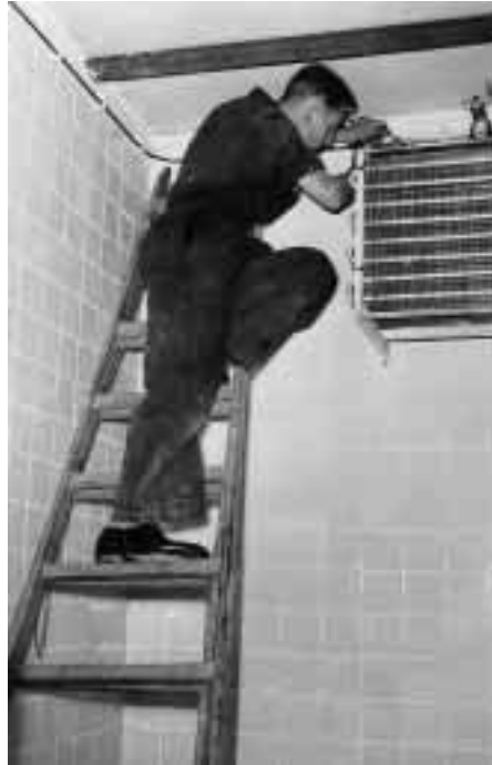
Etwa 1952: Eine moderne Kälteanlage entsteht. Hans-Hermann Schrot bei der Montage. Rohrleitungen werden verlegt (linkes Bild oben), „Apparate“ werden angeschlossen (Mitte oben) und die Schalttafel verklemmt (rechtes Bild oben). Schließlich wurde die offene wassergekühlte Kältemaschine beim Metzger installiert (linkes Bild unten). Vor der Übergabe prüft der Meister die Temperatur (mittleres Bild unten) und die Arbeitsdrücke (rechtes Bild unten). Herbert Emke (Elektro Weber, Emden) galt in den 50er Jahren als anerkannte Koryphäe im Emdener Raum und war für Hans-Hermann Schrot ein guter Lehrmeister.
