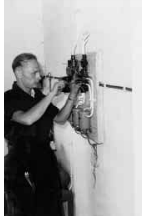
Etwa 1952: Eine moderne Kälteanlage entsteht. Hans-Hermann Schrot bei der Montage. Rohrleitungen werden verlegt (linkes Bild oben), „Apparate“ werden angeschlossen (Mitte oben) und die Schalttafel verklemmt (rechtes Bild oben). Schließlich wurde die offene wassergekühlte Kältemaschine beim Metzger installiert (linkes Bild unten). Vor der Übergabe prüft der Meister die Temperatur (mittleres Bild unten) und die Arbeitsdrücke (rechtes Bild unten). Herbert Emke (Elektro Weber, Emden) galt in den 50er Jahren als anerkannte Koryphäe im Emdener Raum und war für Hans-Hermann Schrot ein guter Lehrmeister.
