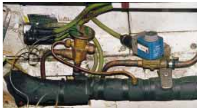
Das corpus delicti vor Beginn der Reparatur. Wie man auf dem Foto erkennen kann, ist vom Expansionsventil der Fühler abgerissen. Da gibt es nun nichts mehr zu reparieren, das E-Ventil war auf die Schnelle auszutauschen. Mal gut, daß Schrot ein derartiges Regelteil in seinem Gepäck dabei hatte, denn sonst hätte er ein zweites Mal auf den Azoren „Urlaub“ machen müssen.
