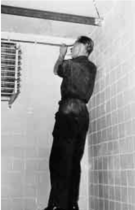
Etwa 1952: Eine moderne Kälteanlage entsteht. Hans-Hermann Schrot bei der Montage. Rohrleitungen werden verlegt (linkes Bild oben), „Apparate“ werden angeschlossen (Mitte oben) und die Schalttafel verklemmt (rechtes Bild oben). Schließlich wurde die offene wassergekühlte Kältemaschine beim Metzger installiert (linkes Bild unten). Vor der Übergabe prüft der Meister die Temperatur (mittleres Bild unten) und die Arbeitsdrücke (rechtes Bild unten). Herbert Emke (Elektro Weber, Emden) galt in den 50er Jahren als anerkannte Koryphäe im Emdener Raum und war für Hans-Hermann Schrot ein guter Lehrmeister.
