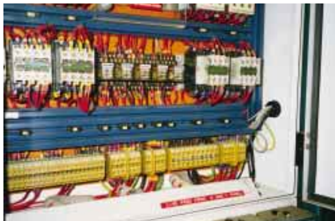
Energie-Spar-Modul Typ EC 4, eingebaut in einem Sainsbury Supermarkt in Farnham (UK).
