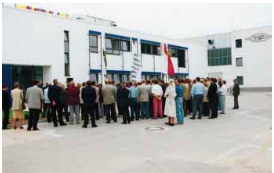
Ein Teil des Fertigungsneubaus von Bitzer in Schkeuditz ist hier sichtbar, der sich mit 5700 m 2 in einer ersten Erweiterungsphase an die bestehende Gebäudefläche (rechts) angliedert.
