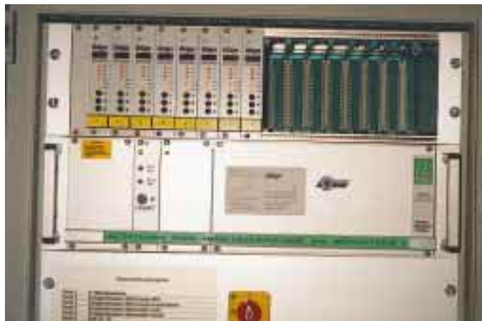
Als wichtigster Punkt der von IKET vorgenommenen sicherheitstechnischen Überprüfung der NH 3 -Kälteanlagen in der Privatbrauerei Stauder wurde die bisher nicht vorhandene Installation einer Gaswarnanlage veranlaßt. Die linke Abbildung zeigt einen Gassensor, die rechte Abbildung die elektronisch gesteuerte Gaswarnanlage.
