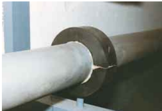
Das A und O bei den zu treffenden Sicherheitsvorkehrungen sind die geröntgten Schweißnähte an absolut korrosionsfrei verlegten Rohrleitungen. Die Abbildungen zeigen hierzu einige Details. Auf der Abbildung links oben ist der Anschluß zur Vorbereitung der Schweißnähte zu sehen. Die Abbildung rechts oben zeigt eine spezielle Kälteschelle. Nach Verlegung erhalten die Rohrleitungen einen 3fachen Spezial-Anstrich (Abb. links unten). Eine gut ausgeführte Isolierung der Rohrleitungen mit Blechmantel (Abb. unten rechts) verhindert eine Korrosion durch Einwirkung von Feuchtigkeit bzw. Schwitzwasser.
