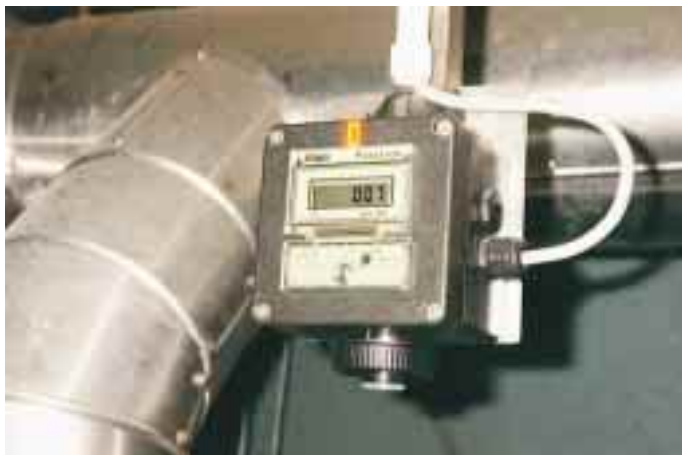
Als wichtigster Punkt der von IKET vorgenommenen sicherheitstechnischen Überprüfung der NH 3 -Kälteanlagen in der Privatbrauerei Stauder wurde die bisher nicht vorhandene Installation einer Gaswarnanlage veranlaßt. Die linke Abbildung zeigt einen Gassensor, die rechte Abbildung die elektronisch gesteuerte Gaswarnanlage.
