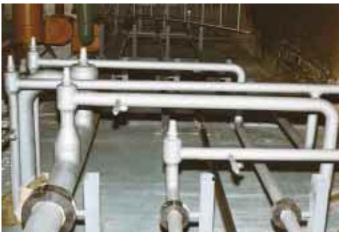
Das A und O bei den zu treffenden Sicherheitsvorkehrungen sind die geröntgten Schweißnähte an absolut korrosionsfrei verlegten Rohrleitungen. Die Abbildungen zeigen hierzu einige Details. Auf der Abbildung links oben ist der Anschluß zur Vorbereitung der Schweißnähte zu sehen. Die Abbildung rechts oben zeigt eine spezielle Kälteschelle. Nach Verlegung erhalten die Rohrleitungen einen 3fachen Spezial-Anstrich (Abb. links unten). Eine gut ausgeführte Isolierung der Rohrleitungen mit Blechmantel (Abb. unten rechts) verhindert eine Korrosion durch Einwirkung von Feuchtigkeit bzw. Schwitzwasser.
