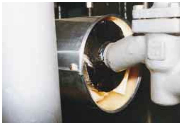
Das A und O bei den zu treffenden Sicherheitsvorkehrungen sind die geröntgten Schweißnähte an absolut korrosionsfrei verlegten Rohrleitungen. Die Abbildungen zeigen hierzu einige Details. Auf der Abbildung links oben ist der Anschluß zur Vorbereitung der Schweißnähte zu sehen. Die Abbildung rechts oben zeigt eine spezielle Kälteschelle. Nach Verlegung erhalten die Rohrleitungen einen 3fachen Spezial-Anstrich (Abb. links unten). Eine gut ausgeführte Isolierung der Rohrleitungen mit Blechmantel (Abb. unten rechts) verhindert eine Korrosion durch Einwirkung von Feuchtigkeit bzw. Schwitzwasser.
