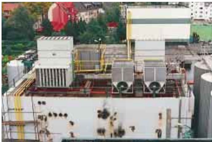
Verdunstungskühler und Verflüssiger. Ein Eindruck von den Dachaufbauten der Neuanlage nach Demontage der nicht mehr benötigten Rohrleitungen der Altanlage.
