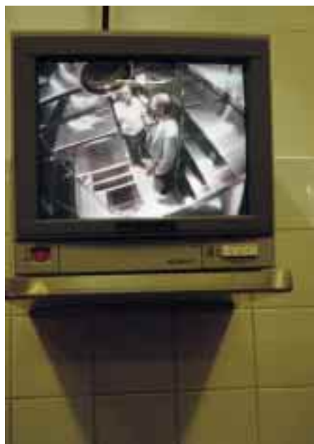
Es ist verboten, den Innenraum der Tiefkühlzellen alleine zu betreten. Von außen wird der Innenraum über einen Fernsehmonitor überwacht. Kältetechnischer Abteilungsleiter Vincent Milsch zeigt auf die Spezialkameras, die im Innenraum montiert sind und die sich von außen steuern lassen.
