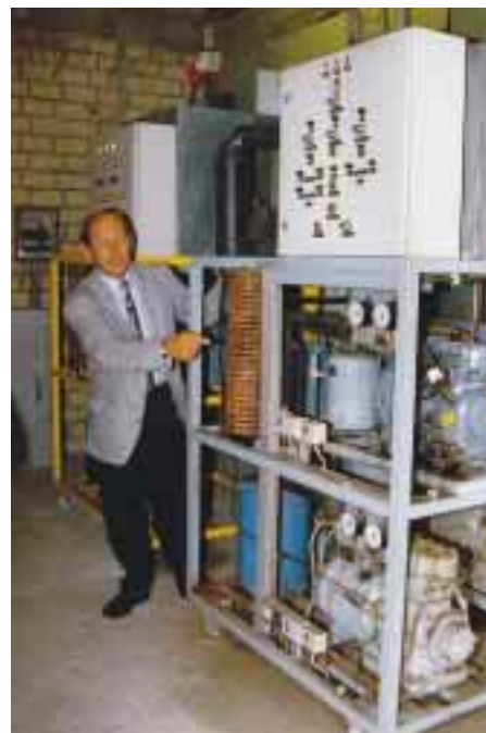
Diese „ältere„ Spezial-Tiefkühlanlage wurde 1980 für eine bis heute einzigartige begehbare Tiefkühlkammer ( -80^{\circ}\text{C} bis -85^{\circ}\text{C} Innenraumtemperatur) von 34\text{ m}^3 Inhalt erstellt und seinerzeit vom heutigen Kältemittel-Fachberater (KLEA-Kältemittel) Franz-Josef Drieling montiert. Das war sein Meisterstück. Kältemittel damals: R 22 für die erste Stufe, R 13 für die zweite Stufe. Zwischenzeitlich schon einmal umgerüstet und durch die Kältemittel R 502 und R 503 ersetzt.
