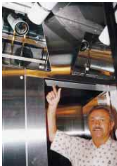
Es ist verboten, den Innenraum der Tiefkühlzellen alleine zu betreten. Von außen wird der Innenraum über einen Fernsehmonitor überwacht. Kältetechnischer Abteilungsleiter Vincent Milsch zeigt auf die Spezialkameras, die im Innenraum montiert sind und die sich von außen steuern lassen.
