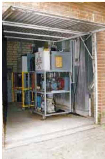
Diese „ältere„ Spezial-Tiefkühlanlage wurde 1980 für eine bis heute einzigartige begehbare Tiefkühlkammer ( -80^{\circ}\text{C} bis -85^{\circ}\text{C} Innenraumtemperatur) von 34\text{ m}^3 Inhalt erstellt und seinerzeit vom heutigen Kältemittel-Fachberater (KLEA-Kältemittel) Franz-Josef Drieling montiert. Das war sein Meisterstück. Kältemittel damals: R 22 für die erste Stufe, R 13 für die zweite Stufe. Zwischenzeitlich schon einmal umgerüstet und durch die Kältemittel R 502 und R 503 ersetzt.
