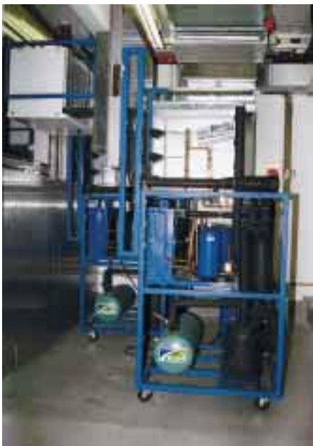
So geht's richtig. Die komplette 2stufige Tiefkühl-Kälteanlage ist auf einem fahrbaren Chassis anschlussfertig montiert und wird von außen hinten an die Tiefkühlzelle heran- und der Ventilatorluftkühler durch die Isolarelemente hineingeschoben. Abdichtung perfekt, keine Schwitzwasserbildung, Innentemperatur im Betrieb -80\text{ }^{\circ}\text{C} .
