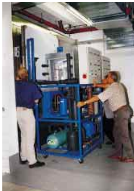
So geht's richtig. Die komplette 2stufige Tiefkühl-Kälteanlage ist auf einem fahrbaren Chassis anschlussfertig montiert und wird von außen hinten an die Tiefkühlzelle heran- und der Ventilatorluftkühler durch die Isolarelemente hineingeschoben. Abdichtung perfekt, keine Schwitzwasserbildung, Innentemperatur im Betrieb -80\text{ }^{\circ}\text{C} .
