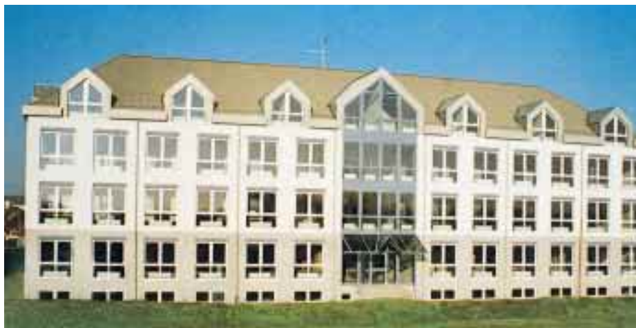
Fassadenansicht (Rückseite) des Europäischen Hauses der Kälte-Klima-Technik in Maintal bei Frankfurt/Main.
