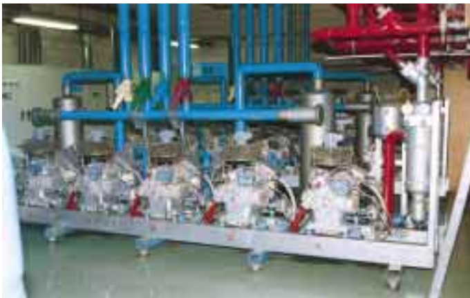
Fotografierverbot im Auchan-Hypermarkt (14 000 m 2 Verkaufsfläche) in Paris, dennoch ein kleiner Eindruck von einer Verdichteranordnung der R22-Verbundanlagentechnik (unten links). Referiert und diskutiert wurde zunächst in der ATO-Unternehmenszentrale in La Défense (unten rechts Monsieur Desprez bei seinem Referat über die Strukturen des französischen Lebensmittelhandels), am nächsten Tag auch in der ehrwürdigen Ecole des Mines de Paris (oben links mit Institutsleiter Dr. Clodic). Schließlich brachte Thomas Schmidtmann (oben rechts) alles auf den Punkt: Nicht nur die Investitionskosten und Energieaufwendungen sind auf die Waagschale zu legen, sondern erst recht die Betriebskosten. Und dann erst ist zu bewerten die Gesamtbilanz jeder „neuen“ Kältemittel-Technologie.
