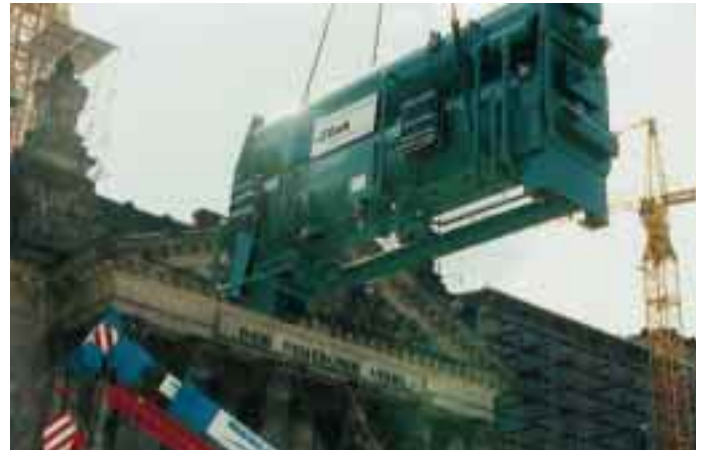
Einbringung des YORK-Absorbers YIA-HW-D8/F2 (Leistung Sommerbetrieb 850 kW, 12/6 °C, 27/39 °C, 110/79 °C; Leistung Winterbetrieb 850 kW, 12/6 °C, 30/42 °C, 110/79 °C) in den Reichstag Berlin.
