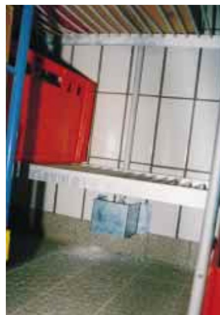
Blick in den Tiefkühlraum. Direktexpansion mit dem Kältemittel R 290 (Propan), der Verflüssiger ist Flo-Ice-gekühlt. Auf der rechten Abbildung ist der durch ein Blech geschützte Sensor für die Propan-Warn- und Alarmanlage zu sehen.
