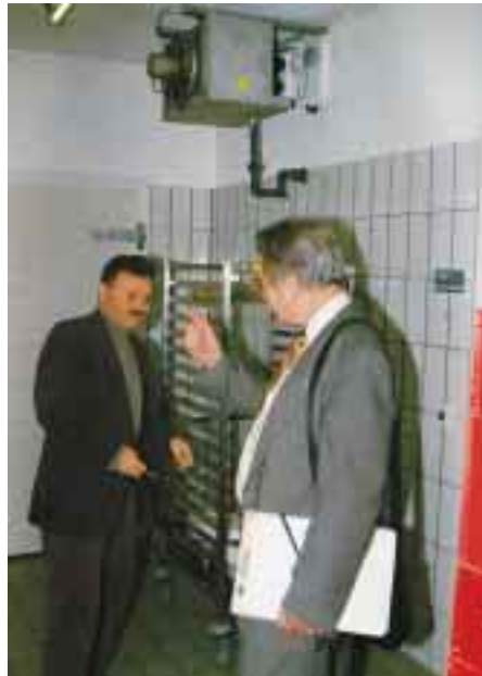
Bei der FCKW-Umrüstung aller im DRK-Krankenhaus Birkenfeld vorhandenen Gewerbekühlräume auf die binäre Flo-Ice-Technik konnten alle vorhandenen Ventilatorluftkühler weiter genutzt und unter der neuen Bezeichnung Kühlstellenaustauscher jetzt mit dem zirkulierenden Flo-Ice-Gemisch weiterbetrieben werden.
