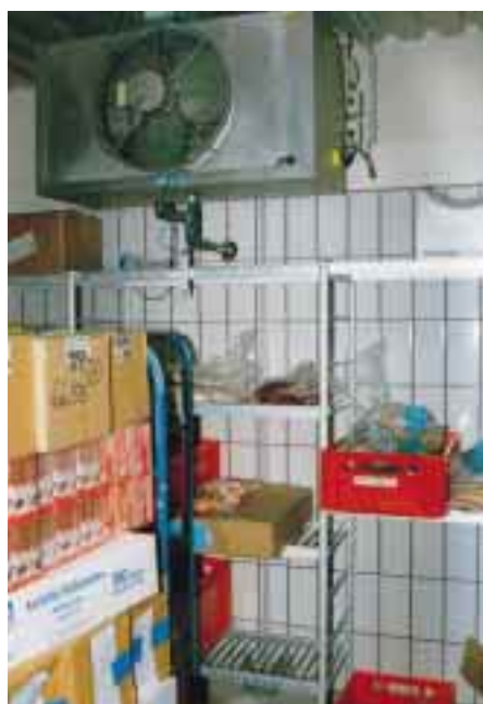
Blick in den Tiefkühlraum. Direktexpansion mit dem Kältemittel R 290 (Propan), der Verflüssiger ist Flo-Ice-gekühlt. Auf der rechten Abbildung ist der durch ein Blech geschützte Sensor für die Propan-Warn- und Alarmanlage zu sehen.
