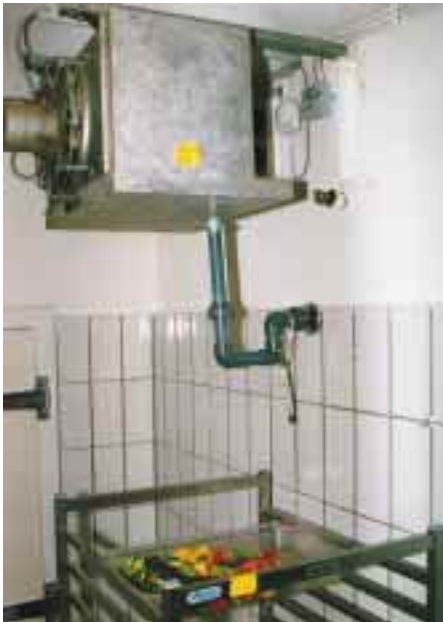
Bei der FCKW-Umrüstung aller im DRK-Krankenhaus Birkenfeld vorhandenen Gewerbekühlräume auf die binäre Flo-Ice-Technik konnten alle vorhandenen Ventilatorluftkühler weiter genutzt und unter der neuen Bezeichnung Kühlstellenaustauscher jetzt mit dem zirkulierenden Flo-Ice-Gemisch weiterbetrieben werden.
