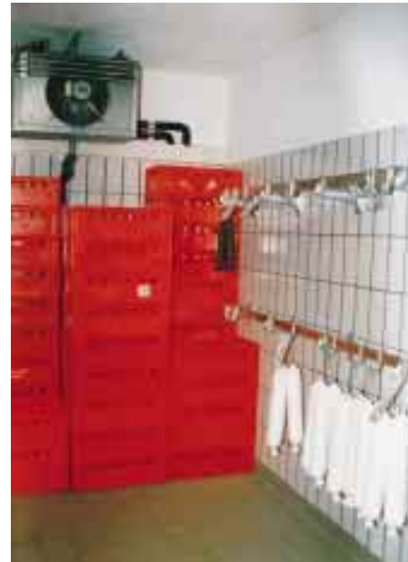
Bei der FCKW-Umrüstung aller im DRK-Krankenhaus Birkenfeld vorhandenen Gewerbekühlräume auf die binäre Flo-Ice-Technik konnten alle vorhandenen Ventilatorluftkühler weiter genutzt und unter der neuen Bezeichnung Kühlstellenaustauscher jetzt mit dem zirkulierenden Flo-Ice-Gemisch weiterbetrieben werden.
