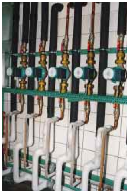
Pumpenbetriebener Flo-Ice-Kreislauf. Die rechte Abbildung zeigt ausschnittsweise den Flo-Ice-Speicher, der ein Volumen von 1,50 m³ besitzt. Die linke Abbildung außen zeigt die Schaugläser, die im Vor- und Rücklauf der Flo-Ice-Ringleitung eingebaut sind.
