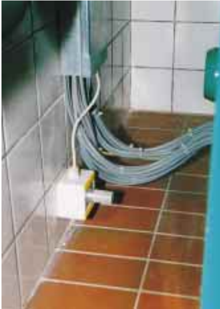
„Neuer“ Maschinenraum für die Flo-Ice-Kältezentrale. Die linke Abbildung zeigt den am Boden befindlichen Sensor für die Propan-Warnanlage, die in der ersten Alarmstufe (Grenzwert ca. 50 ppm) die EX-geschützte extern befindliche Maschinenraumentlüftung einschaltet. Auf der mittleren Abbildung sind die Generatoren mit aufgesetzten Getriebemotoren für die Flo-Ice-Erzeugung zu sehen, auf der rechten Abbildung der luftgekühlte Kanalverflüssiger.
