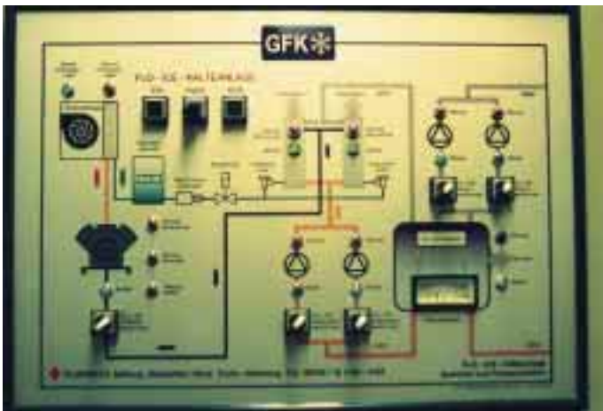
Die gesamte SPS-Steuerung ist in einem zentralen Schaltschrank untergebracht, der weitergehend an die bereits vorhandene Gebäudeleittechnik angeschlossen ist und somit eine Prozeßvisualisierung und Datenerfassung ermöglicht. Die linke Abbildung zeigt die Flo-Ice-Kälteanlage mit Speicher und Pumpenstation, die rechte Abbildung das Flo-Ice-Rohrsystem, die Kühlstellen und die Tiefkühl-Kälteanlage.
