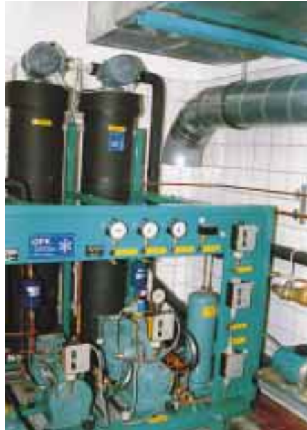
„Neuer“ Maschinenraum für die Flo-Ice-Kältezentrale. Die linke Abbildung zeigt den am Boden befindlichen Sensor für die Propan-Warnanlage, die in der ersten Alarmstufe (Grenzwert ca. 50 ppm) die EX-geschützte extern befindliche Maschinenraumentlüftung einschaltet. Auf der mittleren Abbildung sind die Generatoren mit aufgesetzten Getriebemotoren für die Flo-Ice-Erzeugung zu sehen, auf der rechten Abbildung der luftgekühlte Kanalverflüssiger.
