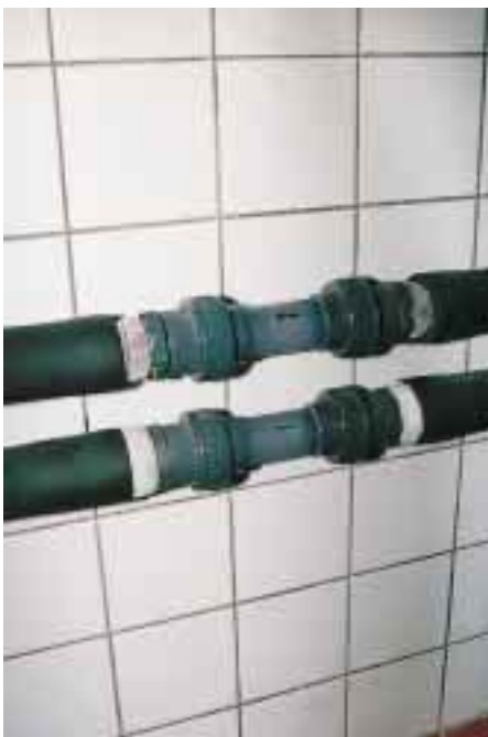
Pumpenbetriebener Flo-Ice-Kreislauf. Die rechte Abbildung zeigt ausschnittsweise den Flo-Ice-Speicher, der ein Volumen von 1,50 m³ besitzt. Die linke Abbildung außen zeigt die Schaugläser, die im Vor- und Rücklauf der Flo-Ice-Ringleitung eingebaut sind.
