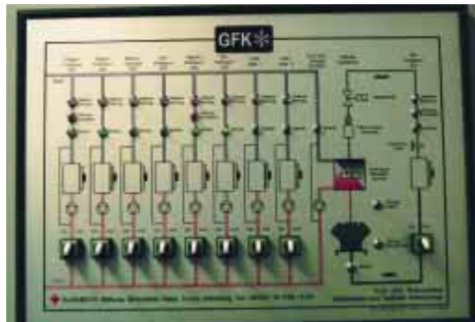
Die gesamte SPS-Steuerung ist in einem zentralen Schaltschrank untergebracht, der weitergehend an die bereits vorhandene Gebäudeleittechnik angeschlossen ist und somit eine Prozeßvisualisierung und Datenerfassung ermöglicht. Die linke Abbildung zeigt die Flo-Ice-Kälteanlage mit Speicher und Pumpenstation, die rechte Abbildung das Flo-Ice-Rohrsystem, die Kühlstellen und die Tiefkühl-Kälteanlage.
