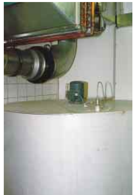
Pumpenbetriebener Flo-Ice-Kreislauf. Die rechte Abbildung zeigt ausschnittsweise den Flo-Ice-Speicher, der ein Volumen von 1,50 m³ besitzt. Die linke Abbildung außen zeigt die Schaugläser, die im Vor- und Rücklauf der Flo-Ice-Ringleitung eingebaut sind.
