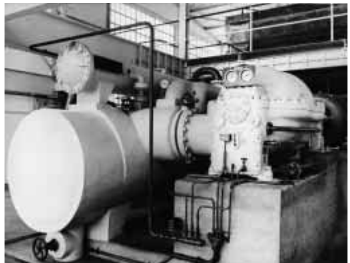
Abb. 8 Turbokältemaschine für eine Chlorverflüssigungsanlage
