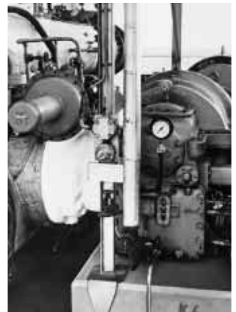
Abb. 14 Turbokältemaschine für eine \text{CO}_2 -Verflüssigungsanlage.
