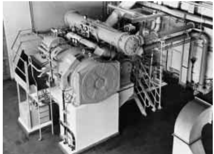
Abb. 15 Schema einer dreistufigen Turbokälteanlage mit Seitenlasten.
