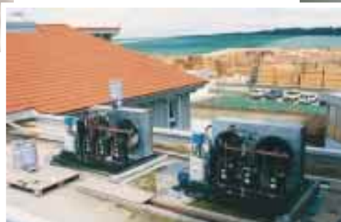
Montage der Verbundsätze auf dem Dach des Zwischentraktes
