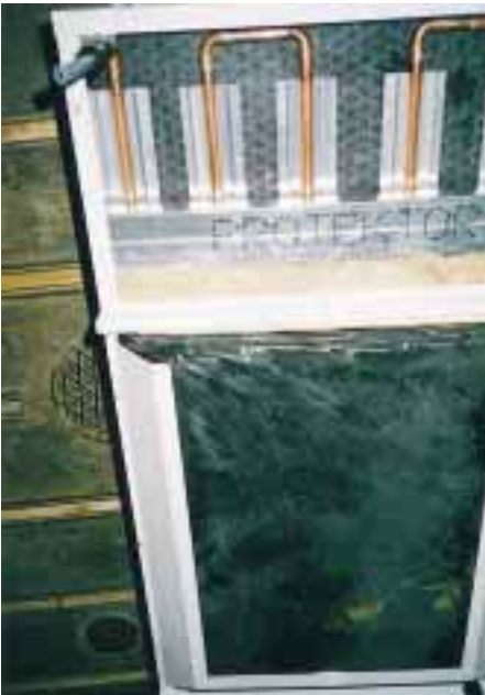
Abb. 1b Kupferrohrmäander und Alu-WLS
