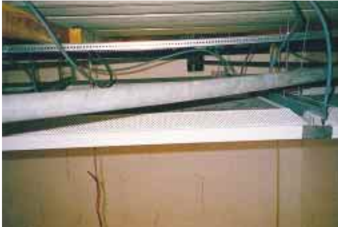
Abb. 7 Deckenhohlraum oberhalb Kühldecke mit aufliegender Dämmung
