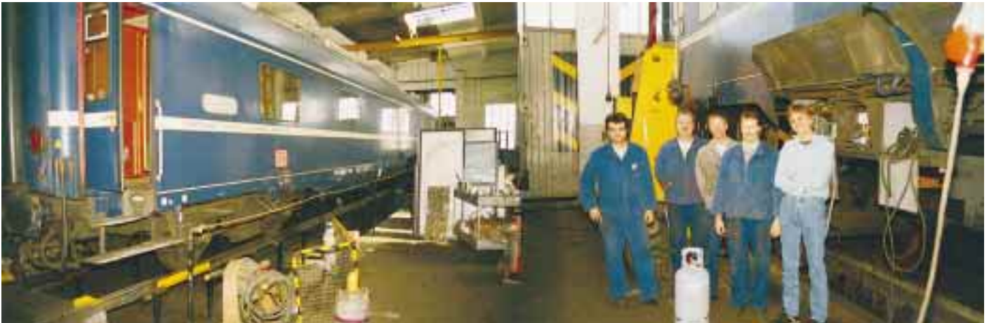
Innerhalb von etwa eineinhalb Jahren wurden 100 Schlafwagen-Waggons der Deutschen Bahn in Neuaußing bei München durch den Umrüstungstrupp von Dipl.-Ing. Helmut Sawitzki (rechts) erfolgreich von R 12 auf das Drop-In-Kältemittel ISCEON 49 (R 413A) umgerüstet
