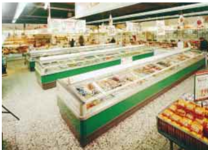
Für Tengelmann entwickelte die Firma Remis GmbH, Köln, eine beschichtete Glasabdeckung für Tiefkühltruhen, durch die der Energieverbrauch um ca. 45 % gesenkt werden konnte
