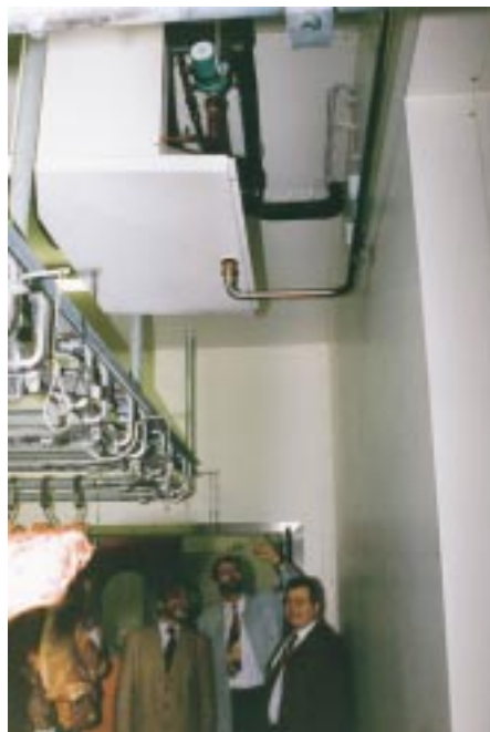
Serienmäßige Ventilatorluftkühler, Fabrikat Güntner, jedoch mit geänderter Funktionszeichnung: „Kühlstellenwärmeaustauscher“. Abweichend von der Serie wurde die Tauwanne
