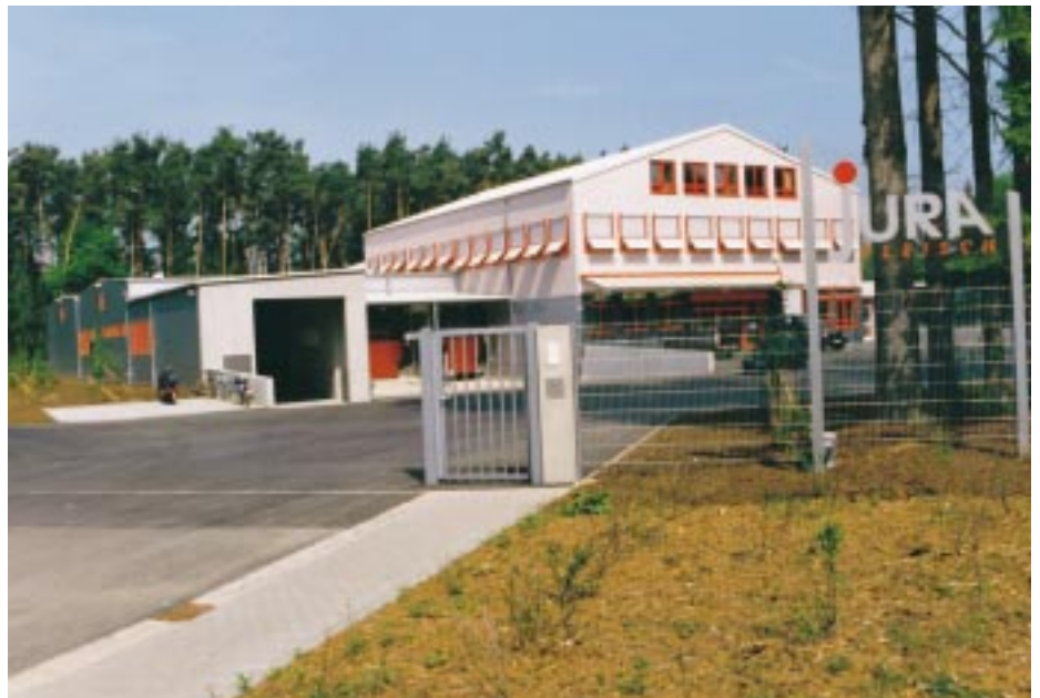
Als „Europas modernster Fleisch- und Wurstproduktionsbetrieb“ wird die neue Betriebsstätte der Jura-Fleisch Versandschlächterei in Neumarkt i. d. Obpf. bezeichnet. 500 Großtiere und 1000 Schweine werden hier wöchentlich verarbeitet und „veredelt“
