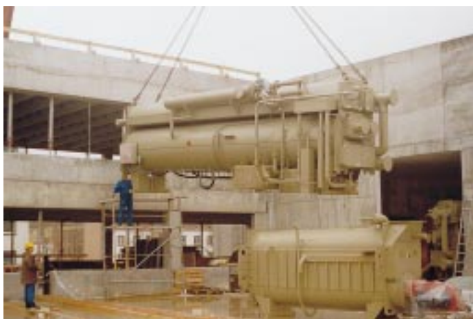
Anlieferung und Einbringung einer von 2 Absorptionsmaschinen von Trane in den Neubau des „Alleecenter in Magdeburg“
