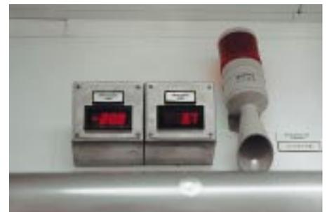
Über jeder Tür gibt es optische Temperaturanzeigen. Daneben ist eine optische und akustische Signalanlage mit 108 Dezibel montiert, die im Gefahrenmoment von Personen innerhalb der Kühl- und Tiefkühlräume betätigt werden kann
