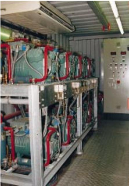
Blick in die Kältemaschinen-Container. Die linke Abbildung zeigt die Plusverbund-Kälteanlagen, rechts ist der Tiefkühlverbund mit Zylinderkopfkühlern des Fabrikates BITZER zu sehen. In beiden Containern sorgen Decken-Klimatruhen des Fabrikates SANYO dafür, daß die Innenraumtemperatur +30 °C nicht übersteigt
