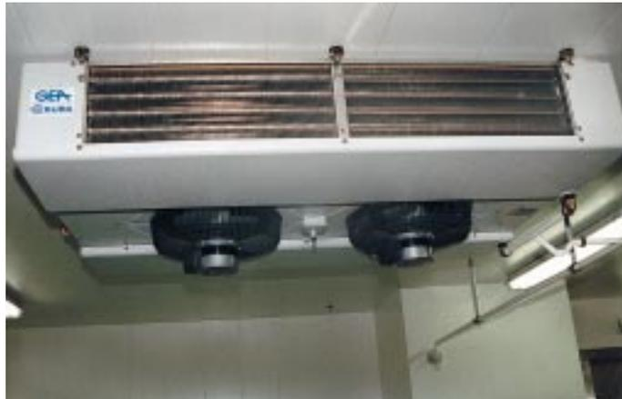
Detailsicht der Ventilatorluftkühler für Deckenmontage des Fabrikates KÜBA in einem Kühlraum. Grundsätzlich wurde von Prause & Partner nur die Type DZB als Verdampfer ausgewählt, weil diese den Lamellen-Sicherheitsabstand von 7 mm besitzen
