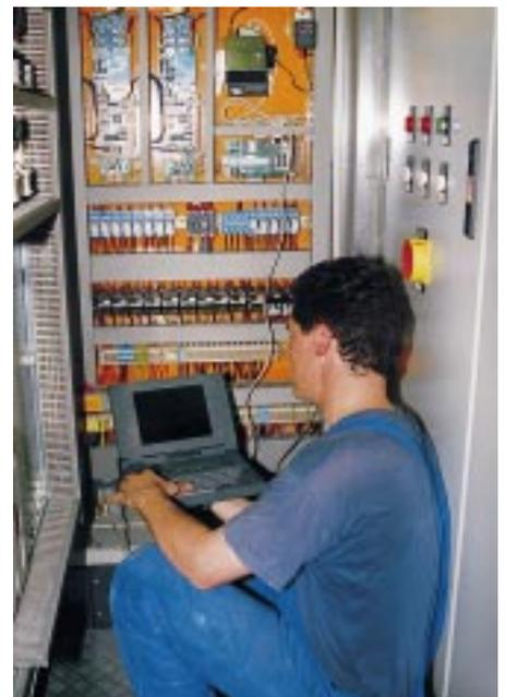
Alle Kälteanlagen werden mit Kühlstellenreglern des Fabrikates DIGITEL elektronisch geregelt und gesteuert. Das gesamte System ist an die zentrale Gebäudeleittechnik angeschlossen und kann auch von Deutschland aus über ein Modem per Telefon und PC kontrolliert und bei Bedarf beeinflusst werden
