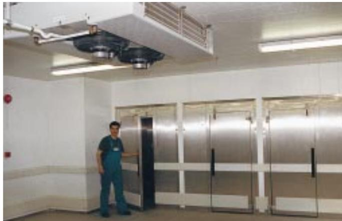
Diese Abbildungen zeigen 3 von insgesamt 6 Schnellabkühlern des Fabrikates WILLIAMS, die von außen direkt an die Kühlräume angeschlossen sind
