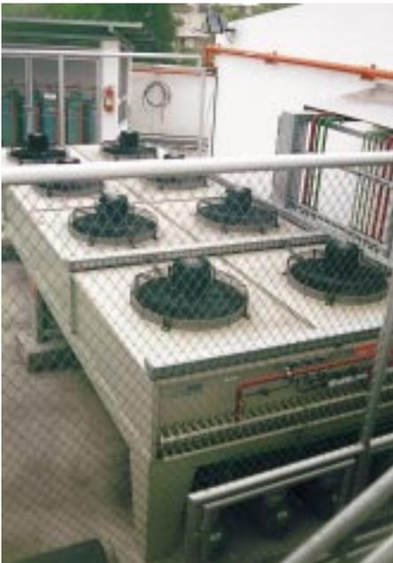
*Für die kältetechnische Versorgung von 15 Kühl-räumen wurde eine Plusverbund-Kälteanlage und für die 2 Tiefkühlräume drei Einzelverdichter installiert. Der luftgekühlte Verflüssiger mit unterteilten Kältemittelkreisläufen und drehzahl-geregelten Axiallüftern steht direkt neben dem Maschinenraum. Der Elektroschalt-schrank ist Eigenbau der Firma Prause & Partner*
