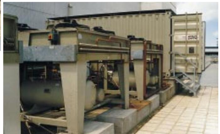
Das heißt, hierbei handelt es sich um Deckenkühler, die einen einheitlichen Lamellenabstand von 7 mm aufweisen. Somit ist eine bei kleineren Lamellenabständen möglicherweise auftretende Vereisung der Lamellen, die eine Leistungsminderung und einen erhöhten Energieverbrauch zur Folge haben könnten, weitgehendst ausgeschlossen.
