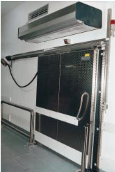
Die Breite dieser automatischen Kompaktschiebetür zum großen Tiefkühlraum beträgt 1,70 Meter. Ein Luftschleier verhindert beim Türöffnen das Eindringen von Wärme
