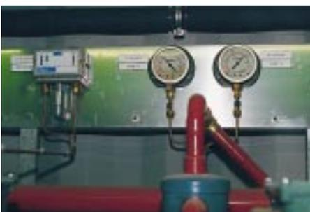
Die Verflüssigerflächen sind so gut ausgelegt, daß bei einer Umgebungstemperatur von +32 °C die Kondensationstemperatur aller Kältemittelkreisläufe nur +39 °C beträgt
