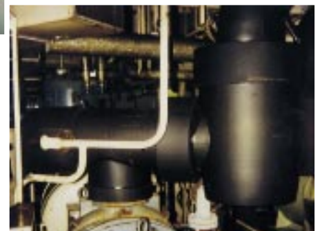
Vorher und nachher. Sauggasleitungen an den Kältemittelverdichtern
