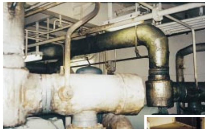
Vorher und nachher. Sauggasleitungen an den Kältemittelverdichtern
