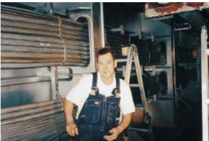
Vorher und nachher. Sauggasleitungen an den Kältemittelverdichtern
