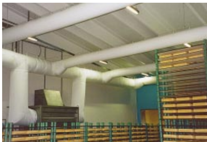
Lüftungsschläuche aus Textilien des dänischen Herstellers KE Fibertec AS eignen sich für vielfältige Anwendungen bei Aufgaben der Luftverteilung in der Kälte- und Lüftungstechnik
