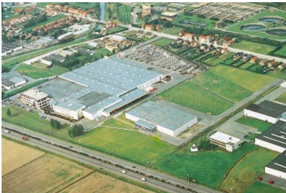
Europäisch klimatisieren. 22 000 m 2 umfaßt das bebaute Areal der DAIKIN EUROPE NV in Oostende, und es wird schon wieder gebaut
