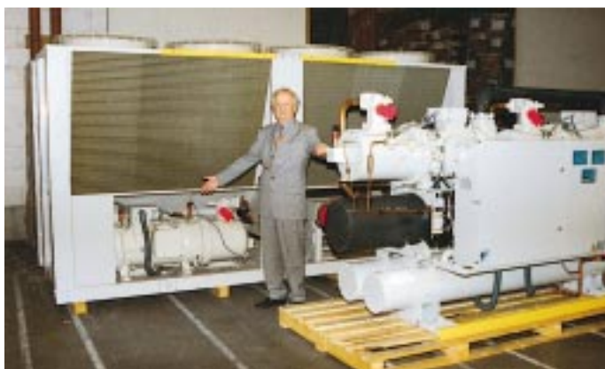
DAIKIN produziert in Oostende auch Kaltwassersätze. Vor und bei der Auslieferung hier zwei R 134a-Erzeugnisse in wasser- und luftgekühlter Ausführung. Versehen mit Schraubenverdichtern aus japanischer Produktion
