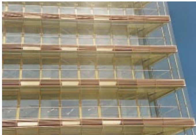
Die Fassade. Die Geschosse sind lufttechnisch und baulich getrennt, in den Decken sind die Luftein- und -auslässe nebeneinander angeordnet. Der Fassadenzwischenraum ist für die Nutzer begebar
