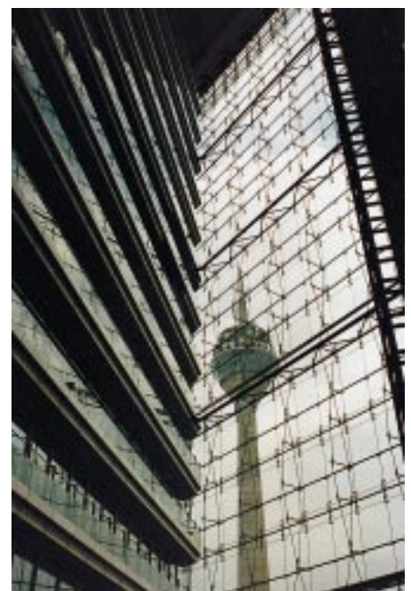
Die zum Fernsehturm hin freie Seite des Atriums mit einer einschaligen Einfachverglasung (Foto: Fachinstitut Gebäude-Klima)
