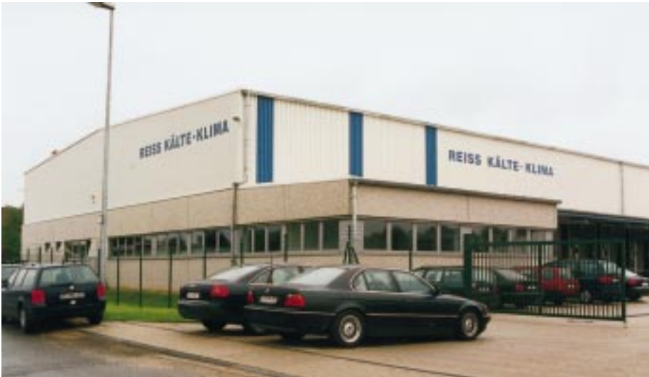
REISS Kälte-Klima in Köln-Wesseling. Am 12. September 1998 konnte in der Vorgebirgsstraße 30 (Gewerbegebiet Rheinbogen) nun auch offiziell das 2400 m 2 umfassende Lager und Verkaufshaus seiner Bestimmung übergeben werden
