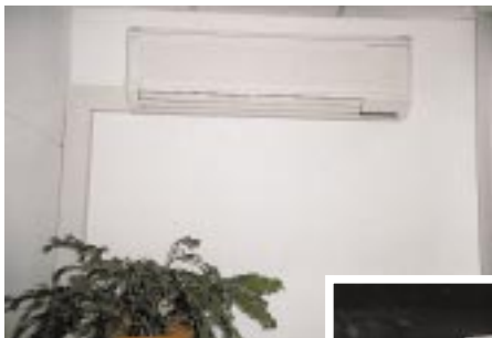
Abb. 12 Innen- und Außenteil eines Splitsystems mit R 410A zur Klimatisierung eines Büros in Lübeck (Foto Carrier)
