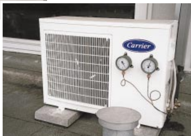
Abb. 12 Innen- und Außenteil eines Splitsystems mit R 410A zur Klimatisierung eines Büros in Lübeck (Foto Carrier)
