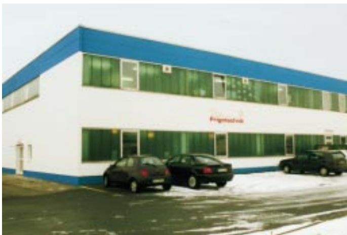
Die Niederlassung Frankfurt der Firma Frigotechnik Handels GmbH mit ihrem neuen Standort in Kriftel mit Anbindung an die A 66
