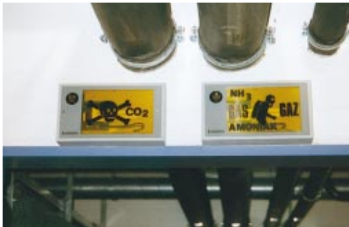
Bild 6 Alarmtransparente über dem Eingang zum Maschinenraum
