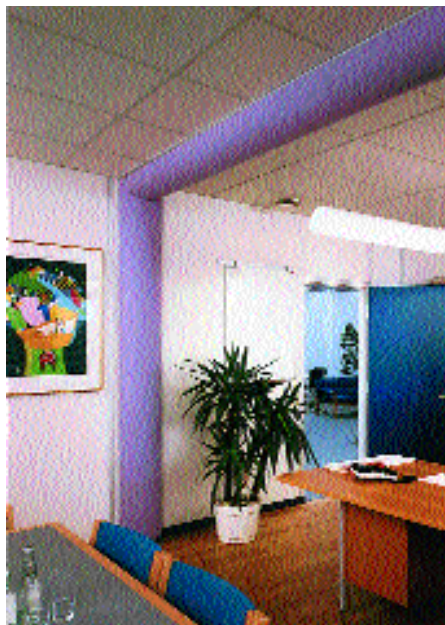
„KE-Interior“, ein textilbasiertes nachrüstbares Quellluftsystem. Erstmals auf der ISH
