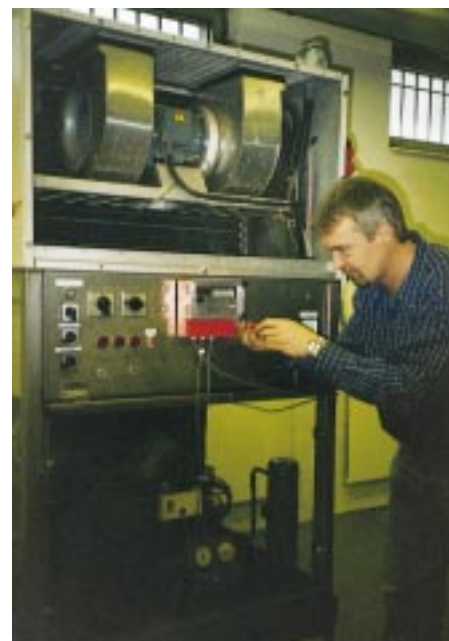
Bild 3 Montage des Überwachungsgerätes an der Kälteanlage
