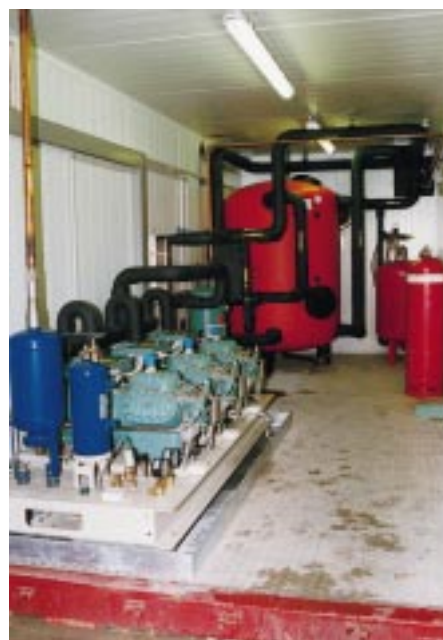
Entsprechend Gelbdruck DIN 7003 ist die Kältezentrale mit 40 kg Kältemittel R 290 Kältemittelfüllvolumen explosionsgeschützt gestaltet
