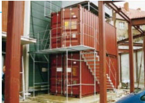
Einer von 13 Verkaufskühlräumen. Die Kühlung wird mit einem Kontaktschalter ausgeschaltet, sobald während der Verkaufszeit die Rolltore geöffnet werden
