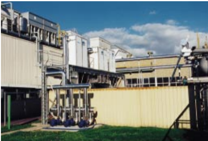
Rostfreie Edelstahl-Rieselfilmwärmetauscher von Buco ersetzen korrodierte Rohrschlangen für die Eiswassertechnik bei Nestlé
