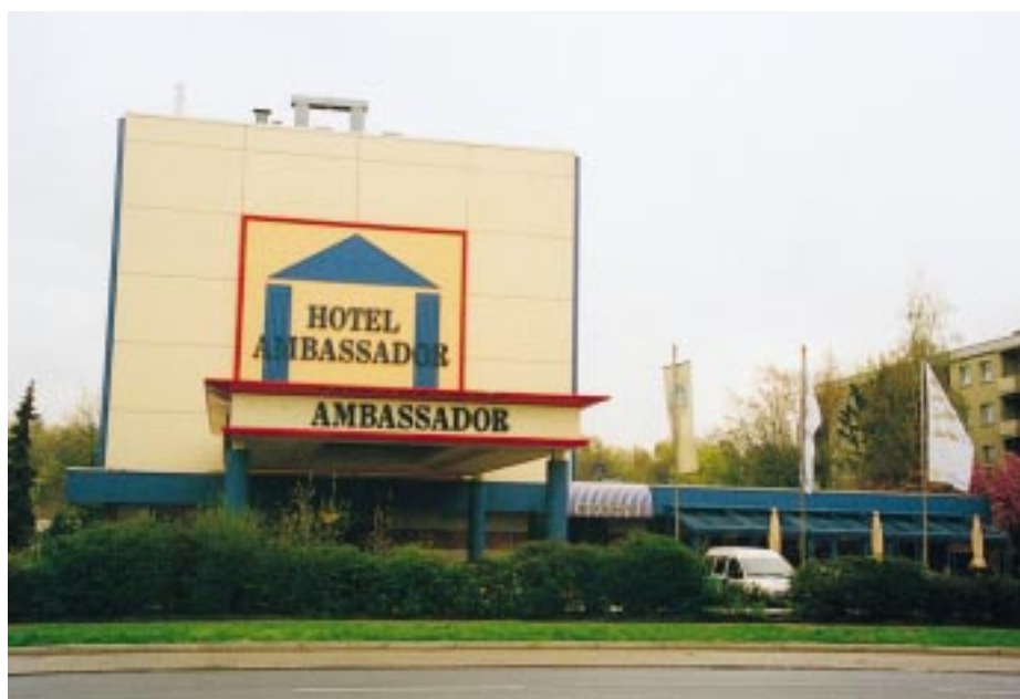
Bild 1 Außenansicht des Hotels Ambassador in Ingolstadt
