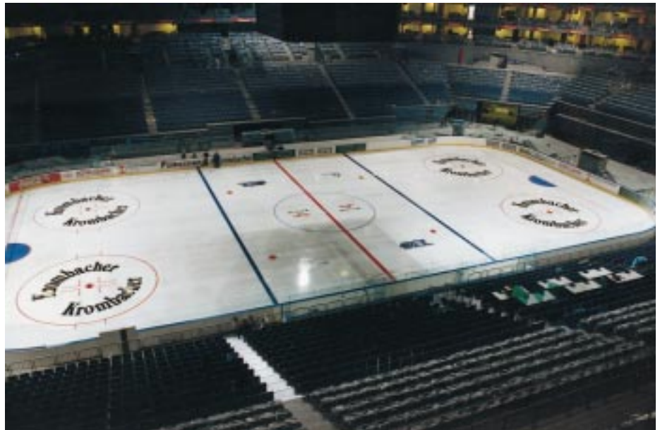
Bild 1 Eisfläche der KölnArena. Aufbringen der ersten Werbeschrift und der Linienmarkierungen bei ca. 3 cm Eisdicke. Spätere Eisdicke nach Wasserbespritzung und Abschleifen ca. 5 cm
