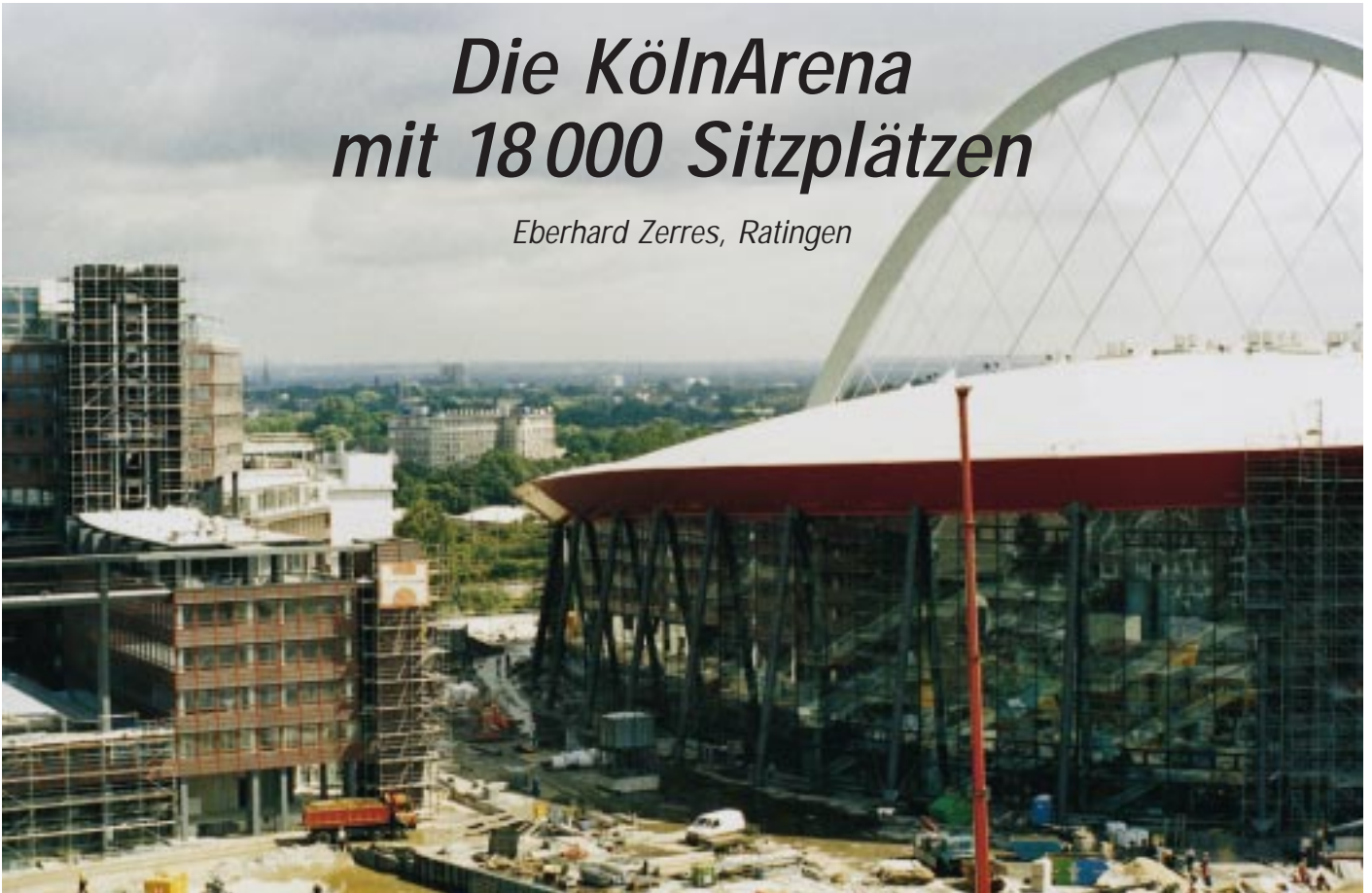
KölnArena in Köln-Deutz während der Bauzeit. Im Herbst 1998 wurde Deutschlands größte und modernste multifunktionelle Veranstaltungshalle eröffnet
