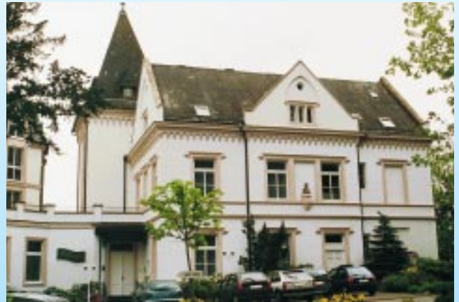
Klimanachrüstung: Schloßhotel & Villa Rheinfels
