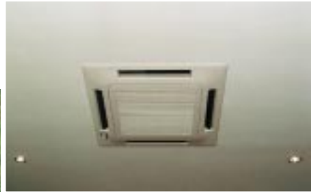
... und innen Kassetten ... – Klimanachrüstung optimal verpackt
