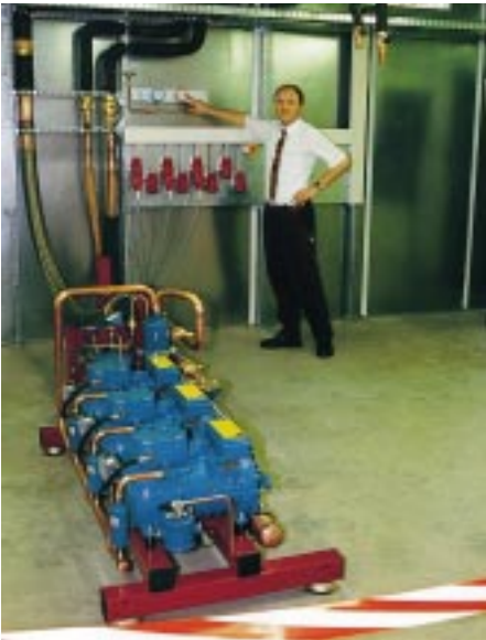
Anlagentest und Prüfbläufe. Hier die Druckstandsprüfung. Prüfdruck 17,93 bar, Prüfdauer 11:57:00 Stunden
