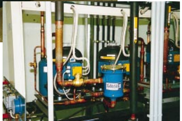
. . . von denen jede mit zwei Trennhäuben-Verdichtern ausgestattet ist
