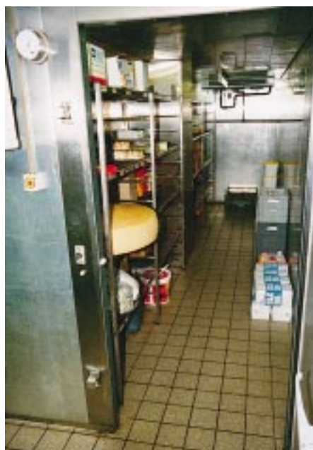
Hier wird die Kälte gebraucht: Bei den Kühlstellen handelt es sich hauptsächlich um Kühlräume sowie um Kühlmöbel, die direkt im Arbeitsbereich der Küche eingebaut sind
