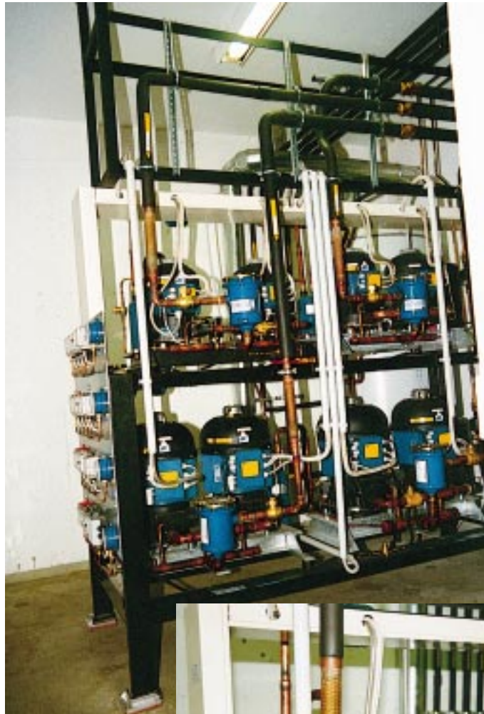
. . . von denen jede mit zwei Trennhäuben-Verdichtern ausgestattet ist
