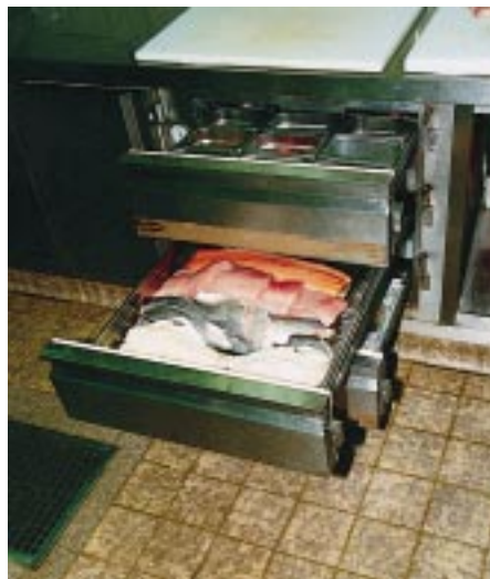
Hier wird die Kälte gebraucht: Bei den Kühlstellen handelt es sich hauptsächlich um Kühlräume sowie um Kühlmöbel, die direkt im Arbeitsbereich der Küche eingebaut sind
