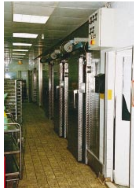
Hier wird die Kälte gebraucht: Bei den Kühlstellen handelt es sich hauptsächlich um Kühlräume sowie um Kühlmöbel, die direkt im Arbeitsbereich der Küche eingebaut sind
