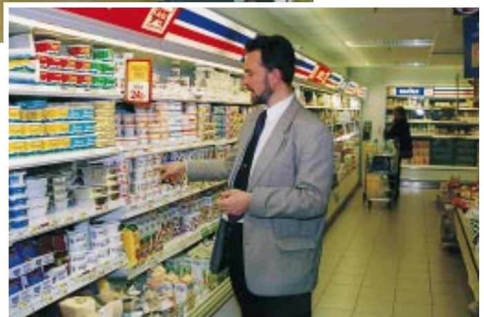
Eine großzügige Prä- sentation von Einzel- produkten steigert den Umsatz um bis zu 20 Prozent. Die Kälteabstrahlung der Kühlregale reicht aus, um diesen Verkaufs- raum ohne zusätz- lichen Energieaufwand zu temperieren
