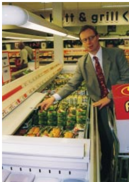
Effiziente Warmsoleabtauung der Tiefkühltruhen mit Temper 20. Keine Reifbildung an den Packungen. Energiesparende Nachtdeckung mit Rollos
