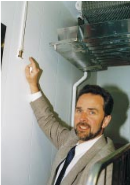
Stille Kühlung ohne Ventilatoreinsatz in den Pluskühlräumen, anstelle eines Thermostates wird die Kälteableitung durch einen Temperatursensor gesteuert
