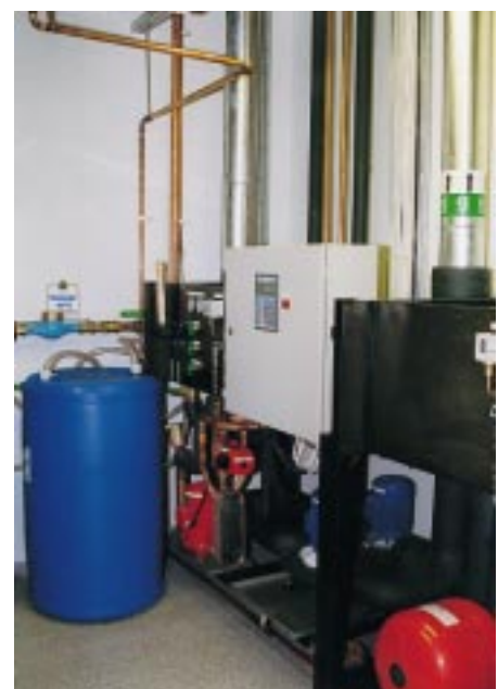
Ein Blick in den Maschinenraum im ICA-Markt. Links die vorgefertigten Flüssigkeitskühler für den Tiefkühlbereich, rechts eine der Pumpenstationen für den Kälte- und Wärmeträgerkreislauf. Im mittleren Bild demonstriert Anlagenbauer Kjell Svensson (rechts) eine gute Zusammenarbeit mit den Repräsentanten von Aspen Temper, Martin Starzmann (Mitte) und Jan Hellsten (links)
