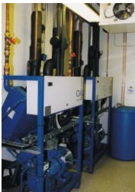
Ein Blick in den Maschinenraum im ICA-Markt. Links die vorgefertigten Flüssigkeitskühler für den Tiefkühlbereich, rechts eine der Pumpenstationen für den Kälte- und Wärmeträgerkreislauf. Im mittleren Bild demonstriert Anlagenbauer Kjell Svensson (rechts) eine gute Zusammenarbeit mit den Repräsentanten von Aspen Temper, Martin Starzmann (Mitte) und Jan Hellsten (links)
