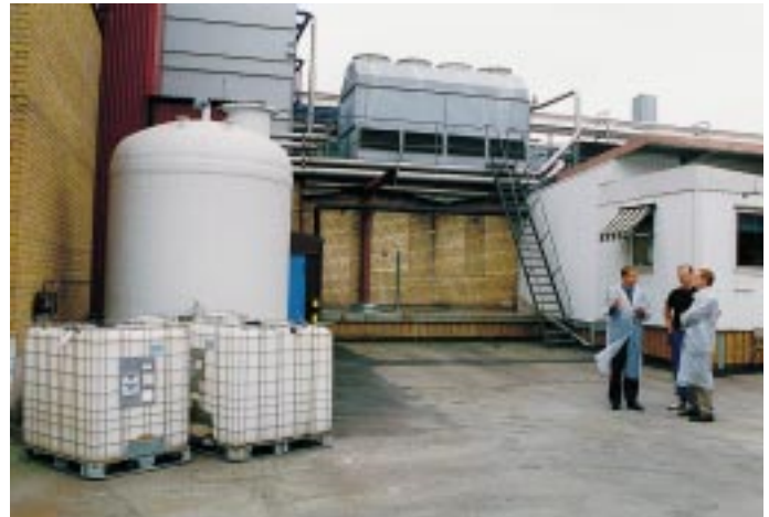
Schlachten und Fleischverarbeitung bei Scan Farmek-Swedish Meats in Uppsala. Seit 1991 Kühlen und Tiefkühlen mit Sekundär-Ammoniak-Kälteanlagen. Insgesamt mehr als 2 MW Kälteleistung, erzeugt durch Hubkolben- und Schraubenverdichter. Seit 1998 ist Aspen Temper 20 und Temper 40 der für Scan ideale Kälte-träger. Die Außenaufnahme zeigt hierfür die Transport- und Lagerbehälter
