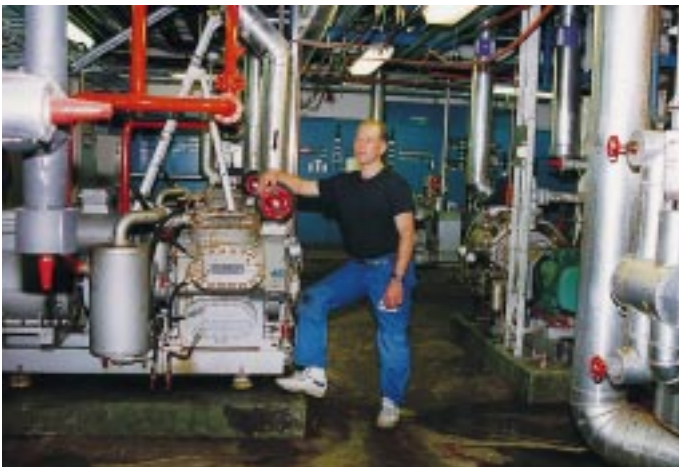
Schlachten und Fleischverarbeitung bei Scan Farmek-Swedish Meats in Uppsala. Seit 1991 Kühlen und Tiefkühlen mit Sekundär-Ammoniak-Kälteanlagen. Insgesamt mehr als 2 MW Kälteleistung, erzeugt durch Hubkolben- und Schraubenverdichter. Seit 1998 ist Aspen Temper 20 und Temper 40 der für Scan ideale Kälte-träger. Die Außenaufnahme zeigt hierfür die Transport- und Lagerbehälter
